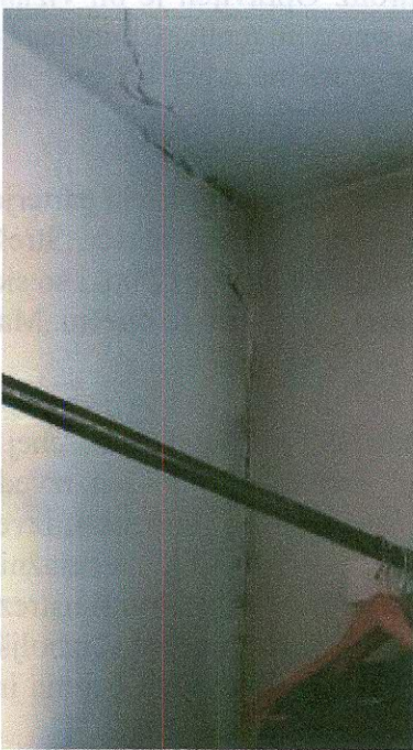
razpoka v zunanji steni iz fasade ob dilataciji v garderobi
